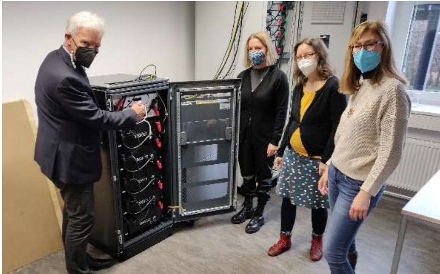
Foto: LUH/Institut für elektrische Energiesysteme
